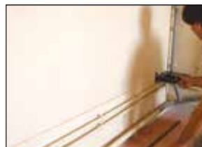
Pose de tuyaux, goulottes Laying conduits and tubes
